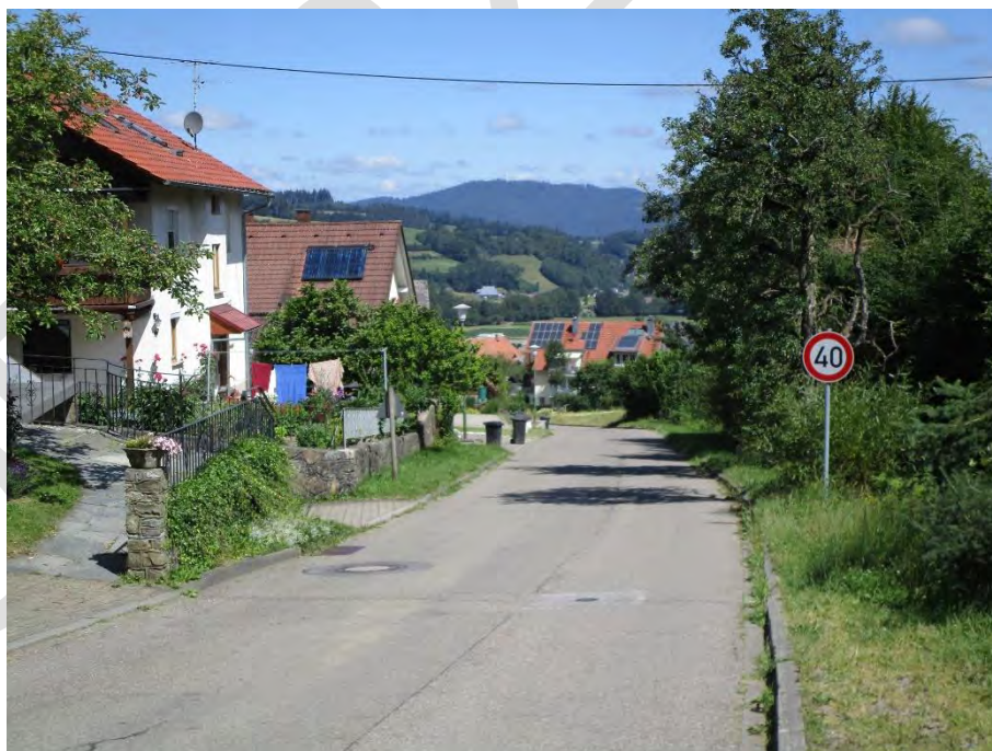
A-Abb. 12: Vörlinsbachstraße unterhalb der Zufahrt zum Campingplatz. Ein Gehweg ist nicht vorhanden.
